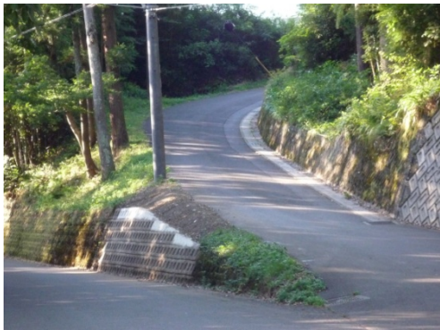
擁壁のブロックがはみ出し、危険な状態でしたが、きれいに修繕されました。施行：桑原工務店
