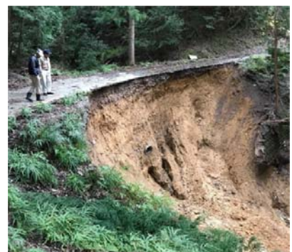
現在も通行止めの大洞林道の土砂崩れ箇所。施工は金山組です。
