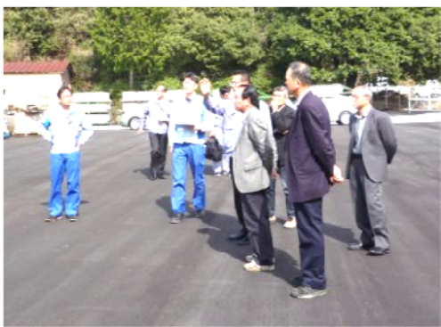
4月17日、産業廃棄物処理場のキャッピング工事の内容や処理施設運用状況について、イビデン(株)のご担当より説明を受けました。
