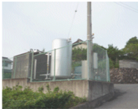
交換された真新しい加圧タンクです。古いタンクは約4半世紀(23年間)も頑張ってくれました。
